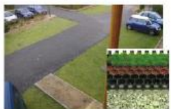
parking dalles alvéolaires enherbées
