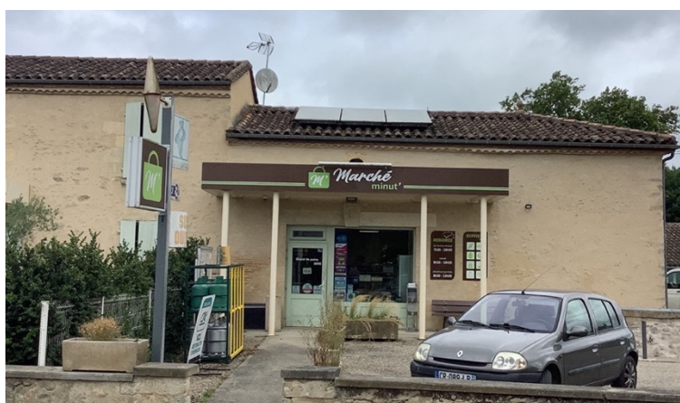
Enseignes sur auvent, Loupiac-De-La Réole, Réolais en Sud-Gironde, juillet 2024.
