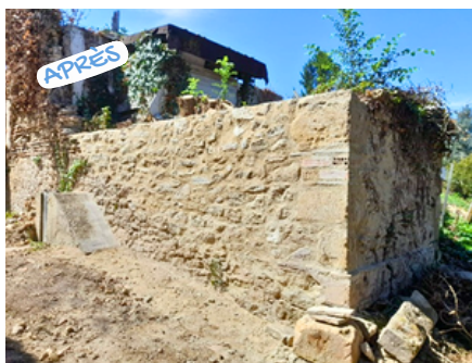
Travaux de restauration d'un mur de digue sur le point de s'effondrer
