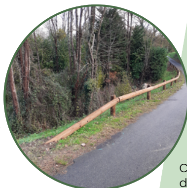
Glissières de sécurité du pont de Marcha à Saint-Sève
