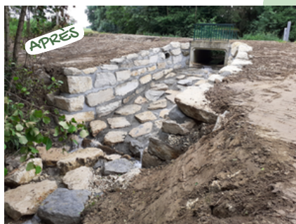
Enrochement du Pont du Lavoir à Loupiac-de-la-Réole
