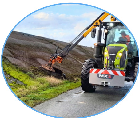
Nettoyage d'une carapace béton
